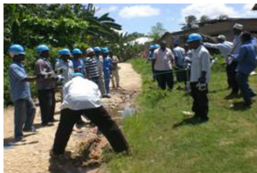
無収水アクションチームに対する 管路補修工事の研修 (2012年)
