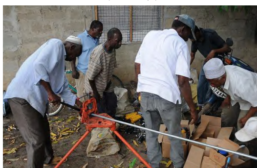
水道メーター設置 (2012年)
