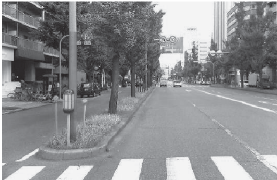
写真 2-23. 緩速車線（大阪市）
