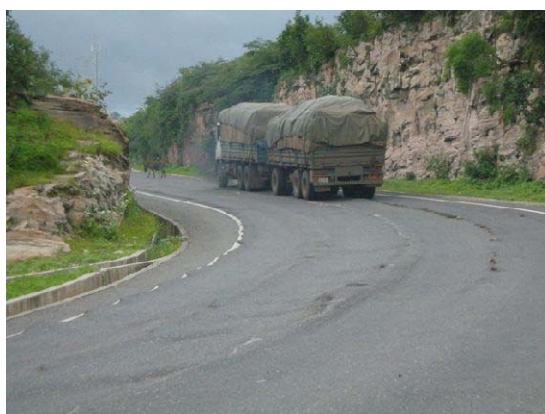
写真2-4. 縦断勾配は7%程度であるが曲線半径の小さな区間であるため速度は10km/h以下である。
