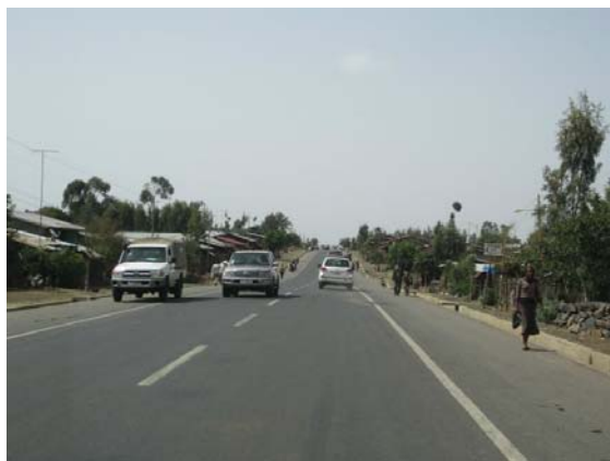
写真 2-22. エチオピア国：国道 3 号線市街地部で沿道からの乗り入れが多いため、路肩の舗装構成を本線と同じにしている。
