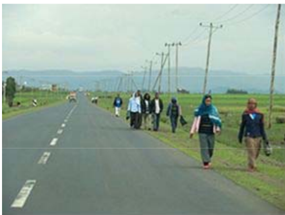
写真 2-18. エチオピア国：国道 3 号線 Phase-I 区間 車道部のみ舗装を行い、路肩は未舗装処理としてい る。
