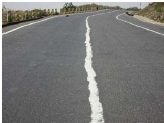
写真2-7. 低速で走行する大型車両が多く見られる山岳道路に発生したコルゲーション。
