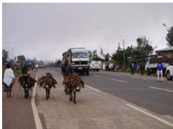
写真 2-19. エチオピア国：国道 3 号線 Phase-III 区間 街中の駐車帯と幅広路肩が多目的に使われている。
