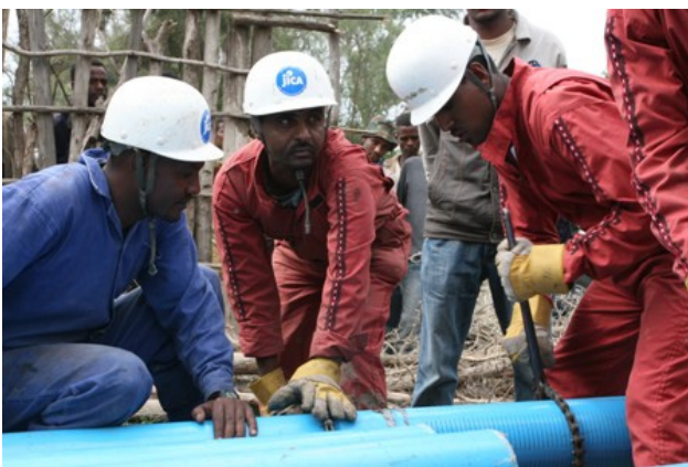
井戸掘削実習の様子(掘削技術コース)。実習で掘削した井戸は生産井として仕上げられ、観測用または給水用に活用される。
