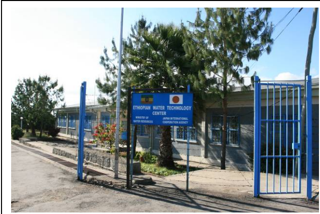
EWTEC 入り口。アデイスアベバの中心から車で約 20 分程度の郊外に位置する。後ろの建物は講師棟。
