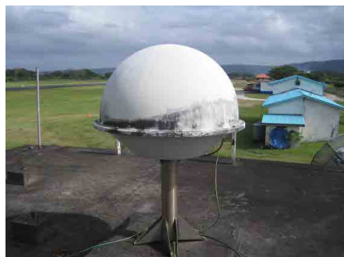
写真 2-1-1 ゾンデ用受信アンテナ
