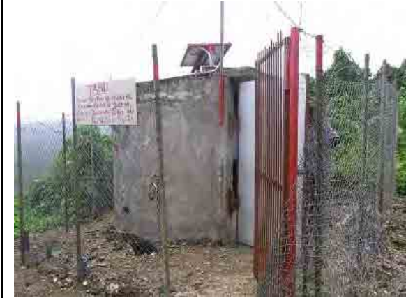
既設の短周期地震計 (エファテ島)
