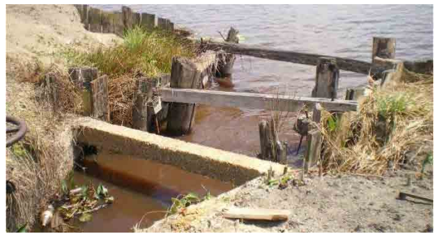
写真 3-1-17 上流側木杭護岸の状況
