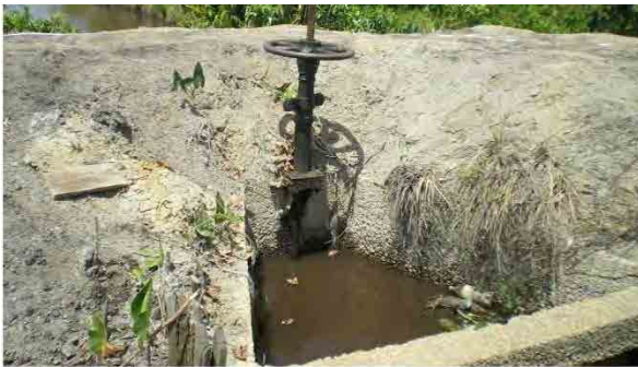
写真 3-1-16 ゲートは正常に機能
