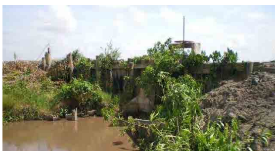
写真 3-1-8 下流側木杭護岸の状況
