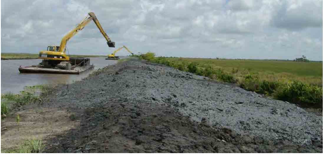
写真 2-2-4 台船～超ロングアーム掘削機による補修作業
