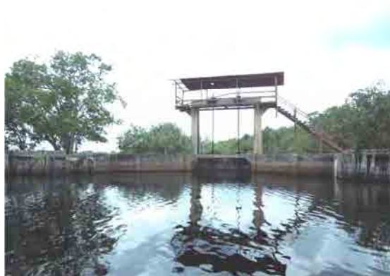
写真 3-1-27 放流工正面のコンクリート 擁壁とゲート
