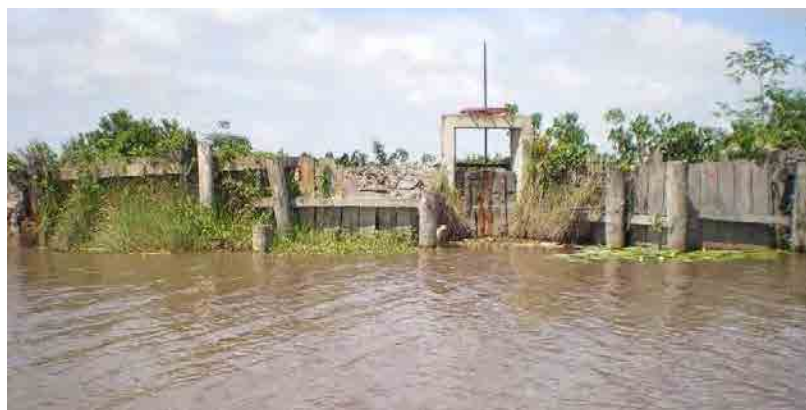
写真 3-1-7 上流側木杭護岸の状況
