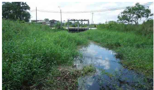
写真 3-1-23 直上流水路の状況
