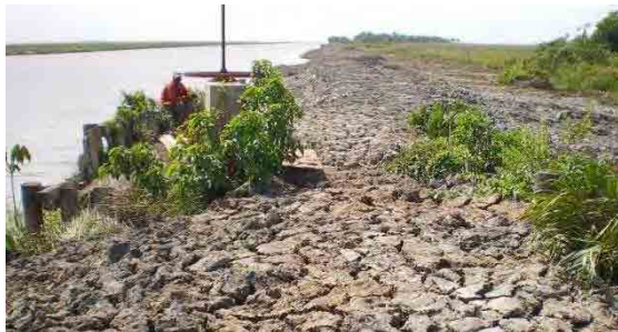
写真 3-1-5 盛土天端と巻き上げハンドル
