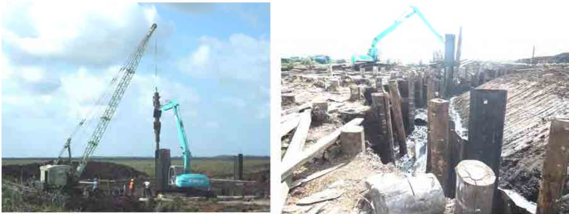
写真 3-1-36 貯水池側放流ゲート部基礎工事、杭打ち作業の状況
