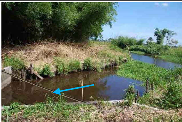
写真-22 ナンシー取水工・呑口側の状況 コンクリート擁壁に異常は認められない。木製護岸工は朽ち果て原型をとどめないが、斜面は安定している。
