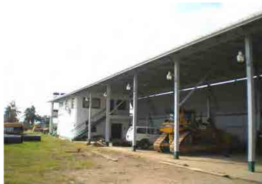
写真 2-1-1 完成したワークショップ建屋
