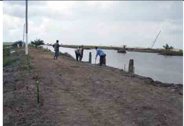
写真-3 フラグスタッフ管理事務所前の資材置場 ホープ・ドックホー放水路建設工事で資材置場として使用されている。
