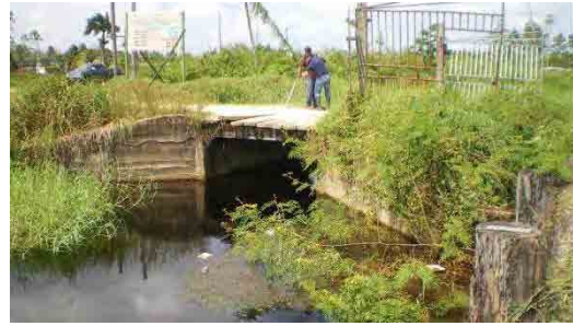
写真 3-1-25 木橋と狭小水路
