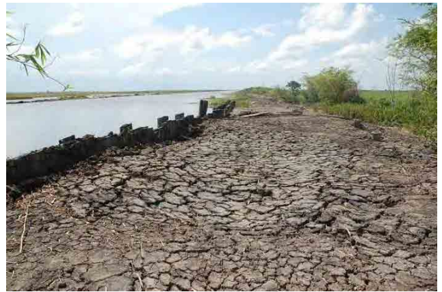
写真-13 アンズ・グローブ取水工付近の堤体 ガ国側による堤体修復工事が完了したところである。取水工埋戻し工事にともない全体的な整形が行われる。
