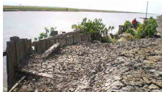
写真 3-1-6 呑み口正面右側の木杭護岸
