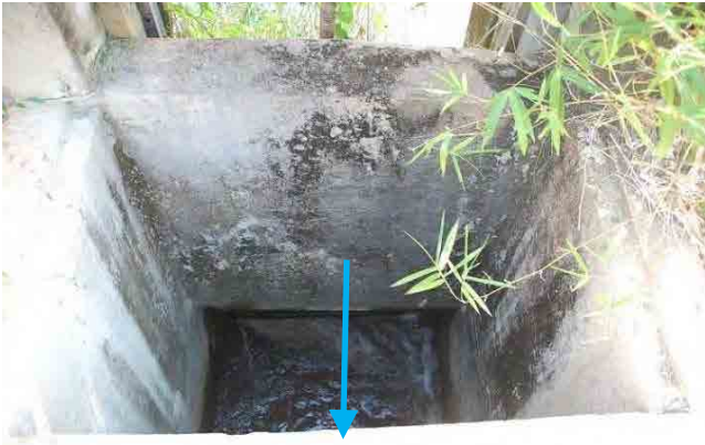
写真-12 アンズ・グローブ取水工本体の現況 Hope Dochfour 建設により、施設が機能しなくなったため、取水施設を埋め戻す。
