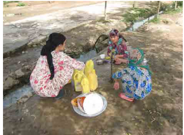
写真10：ピアンジ町内の給水栓 時間給水で且つ給水圧が低いため、蛇口は常時開放されており、無駄水の原因になっている。
