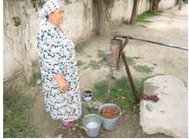
写真2：生活用水源の浅井戸 小口径の鉄管を地面に打ち込んだだけの浅井戸。対象サイトの主な生活用水源となっている。
