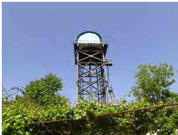
写真5：ボドカナルの既存高架水槽 100m 3 と容量が小さいため、水需要の時間変動に対応できず、ピーク時に空になることが多い。
