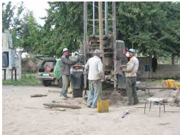
写真 14：ボーリング調査
