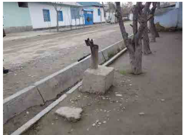
写真4：ハンドポンプ付き井戸 道路沿いのハンドポンプ付き井戸。住民による維持管理がされず、故障後は放置されている。
