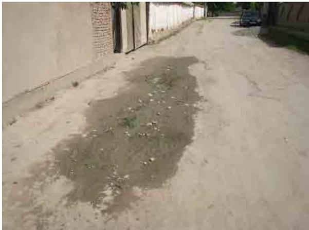
写真9：ピアンジ町内の漏水状況
