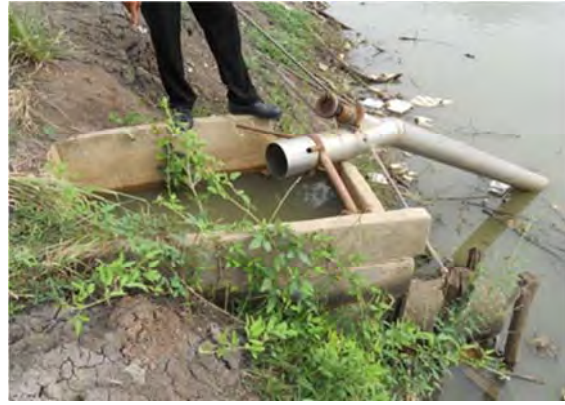
Fig: Pipe Culvert
