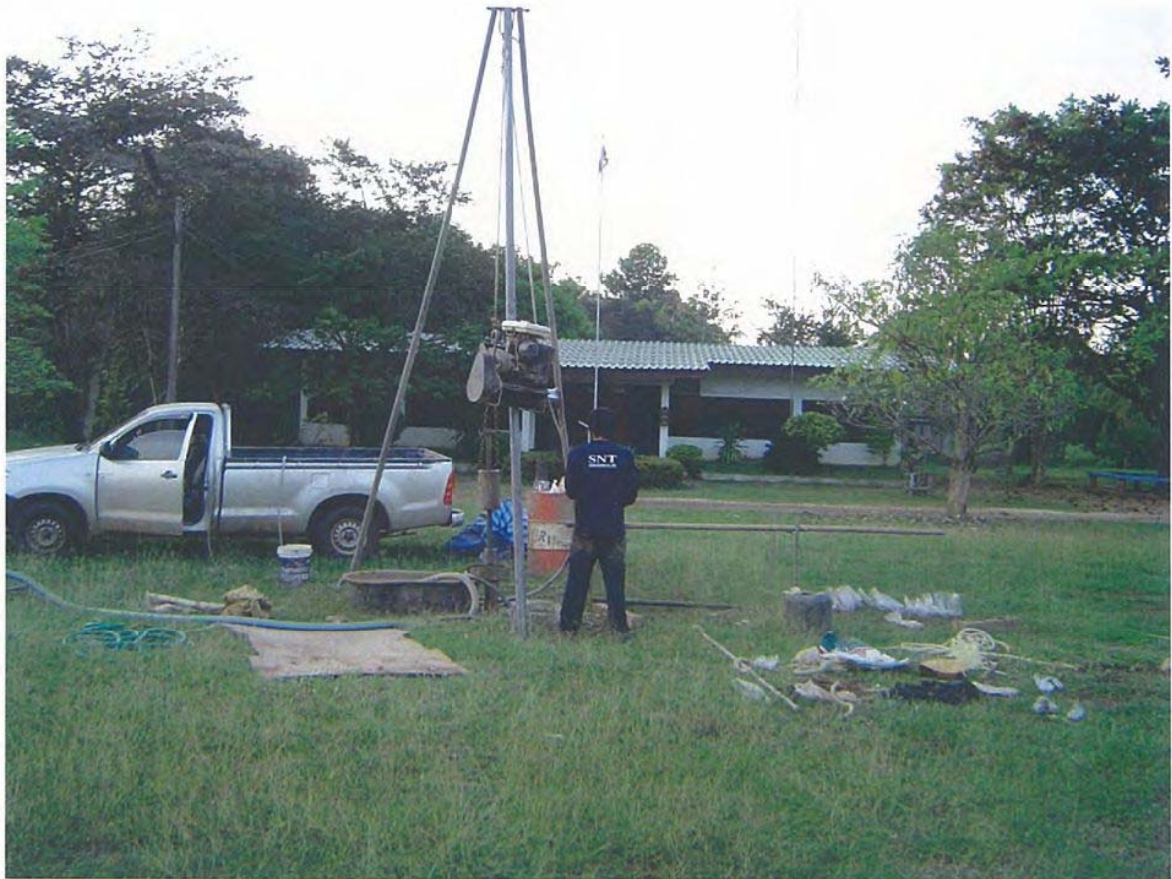
รูปแสดงการเจาะสำรวจและตอกทดสอบบริเวณหลุมเจาะ BH-17
