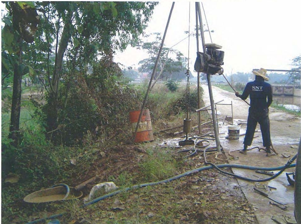
รูปแสดงการเจาะสำรวจและตอกทดสอบบริเวณหลุมเจาะ BH-20
