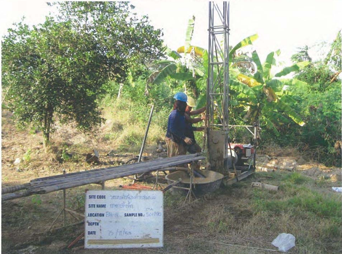
รูปแสดงการเจาะสำรวจและตอกทดสอบบริเวณหลุมเจาะ BH-18
