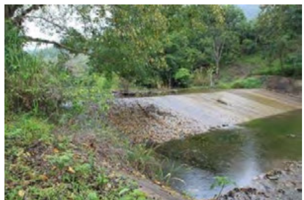
2012/7/18, Spillway of Mae Di Noi Reservoir
