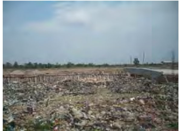
パレンバン市北部最終処分場（TPA-II）における公共事業省の衛生埋立処分場セル建設サイト（竹の柵で囲まれた部分）
