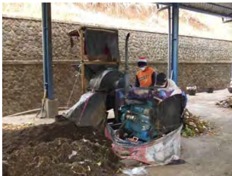
図 2-2-8 バツ新処分場に併設されたコンポスト施設
