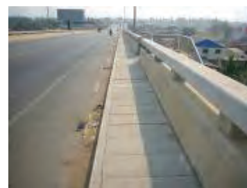
新設の橋（友好橋の上流）
