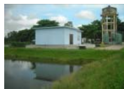
ゴウラダ除鉄装置全景
