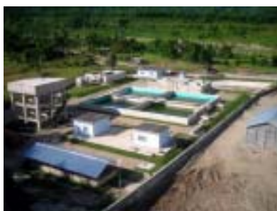
ドゥラバリ浄水場全景
