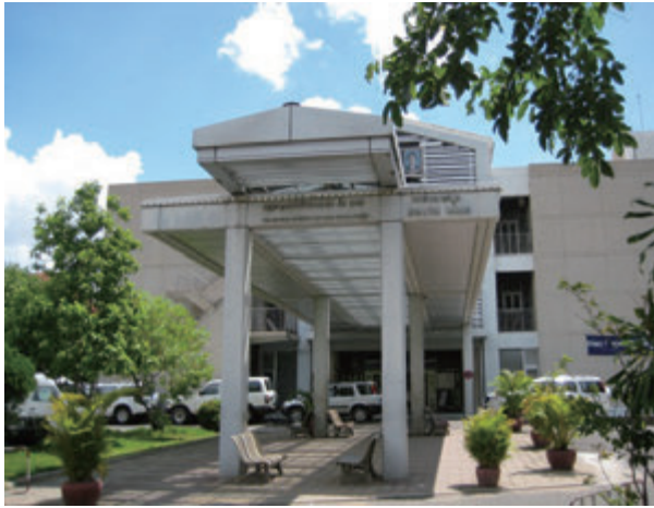
国立母子保健センター（NMCHC）外観
