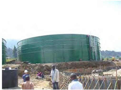
給水タンク工事（一基 4,000m<sup>3</sup> 合計 3 基、当面 2 基で運用）
