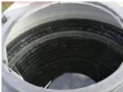
多数存在する屋上タンク ノーメンテの実態(蓋もなく、クモの巣が張っている)
