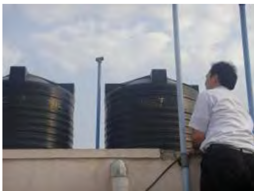
多数存在する屋上タンク ノーメンテの実態(蓋もなく、クモの巣が張っている)
