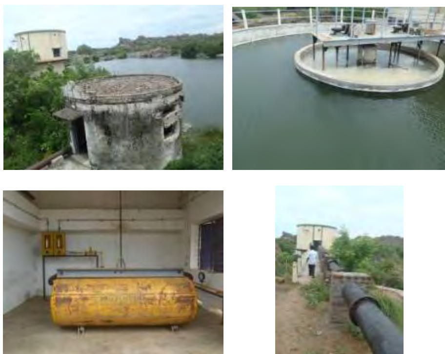
写真 7 タミル・ナドゥ州（農村部）の浄水施設
