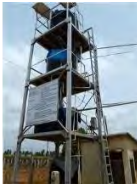
写真 8 未稼働の水処理施設
