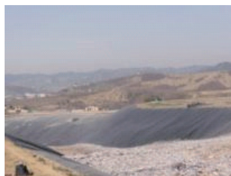
遮水工がされた Sharra 最終処分場
