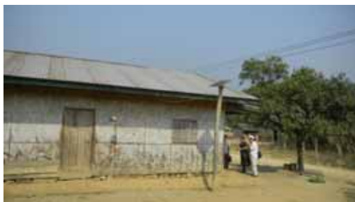
SHS 設置住宅 (配電線電化と共用)
