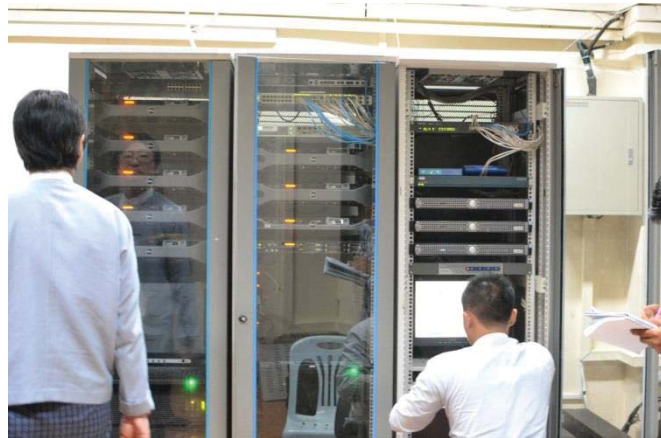
写真 J：CBM ネピドー本店のサーバラック。現行システムのサーバが格納されている。
