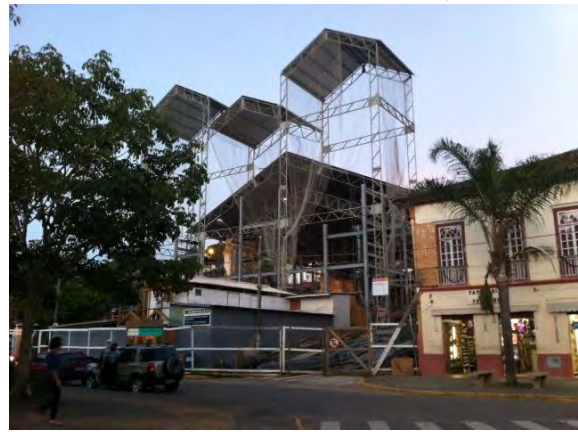
サンパウロ州サンルイスドバラエティンガ（洪水被災地）2ー被災した教会の修復
