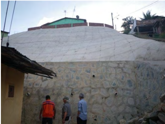
ペルナンブーコ州カポデサントアゴスティーニョ ー斜面对策工
