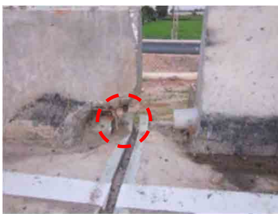
埋設部とつながれていない管路及び詰まっている管路（下側）
