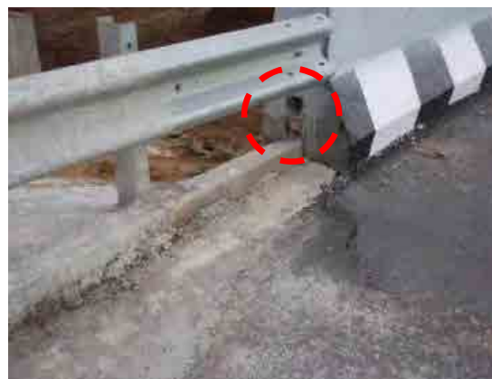
管路の高さが異なり、管路の半分はコンクリー 埋設部とつながれていない管路及び詰まっ
