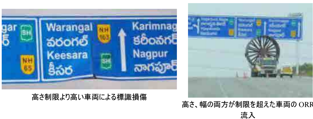
図 11.36: 過積載車による被害
