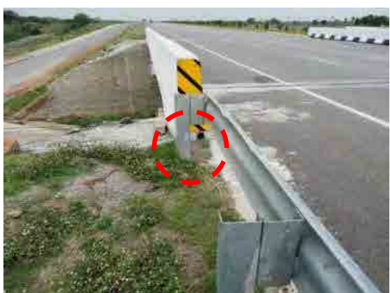
埋設部とつながれていない管路及び詰まっている管路（下側）
