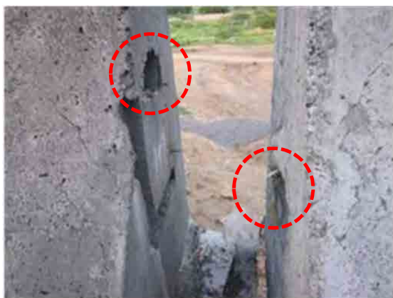
管路の高さが異なり、管路の半分はコンクリー 埋設部とつながれていない管路及び詰まっ
