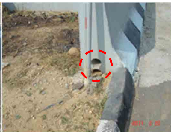
埋設部とつながれていない管路及び詰まっている管路（下側）
