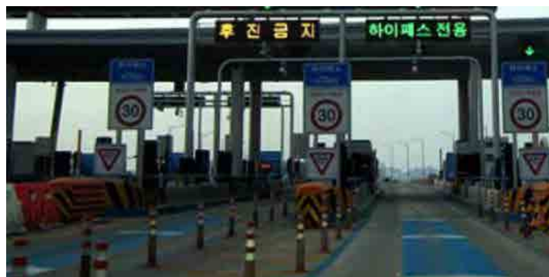
韓国の例(Incheon 橋)
