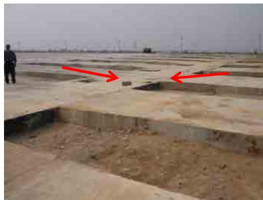
水平でない料金レーン、ブース部に向かって傾いている
