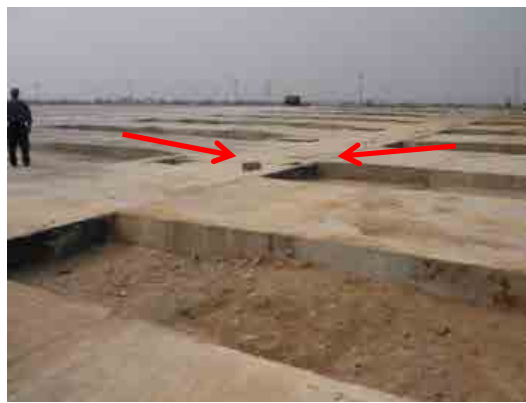
水平でない料金レーン、ブース部に向かって傾いている
