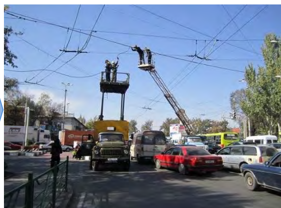
4. Протяжка кабеля
