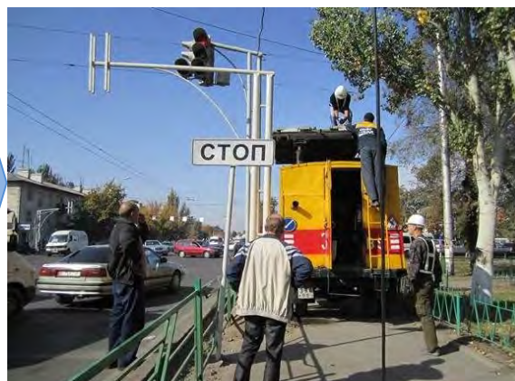
2. Установка светофорных опор
