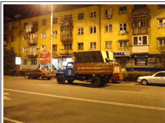
Установка оборудования МП "Тазалык" ночью до начала мероприятия
