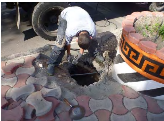
1. Ямы для установки светофорных опор
