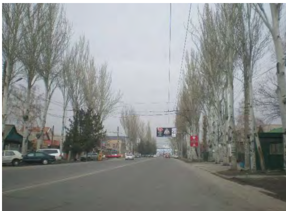
Нанесена осевая линия, но не нанесены разделительные линии движения по полосам
