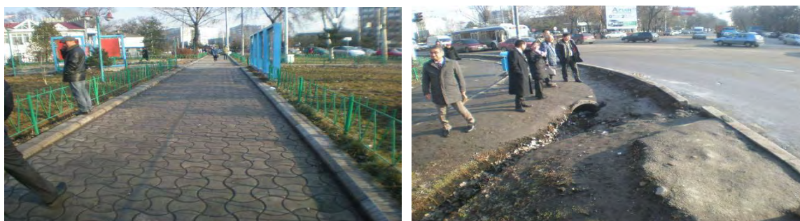
Разрушенная дренажная система и «оборванный» пешеходный тротуар
