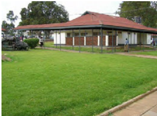
手術・産科病棟建設予定地:既存手術棟を解体した跡地を使用する。
