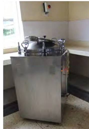
CSSD 滅菌器：現在も頻繁に使用されているが、旧型のためスペアパーツの購入が難しくなっている。
