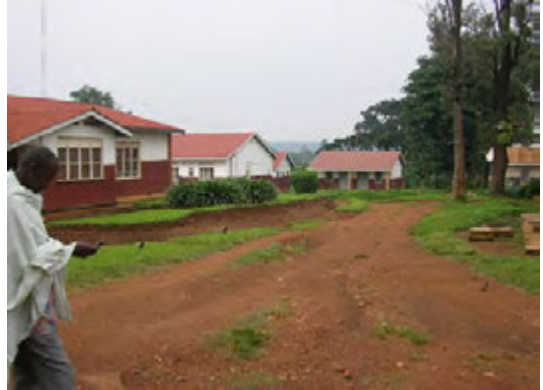
手術・産科病棟建設予定地：老朽化した既存手術棟と厨房を解体した空地を使用する。
