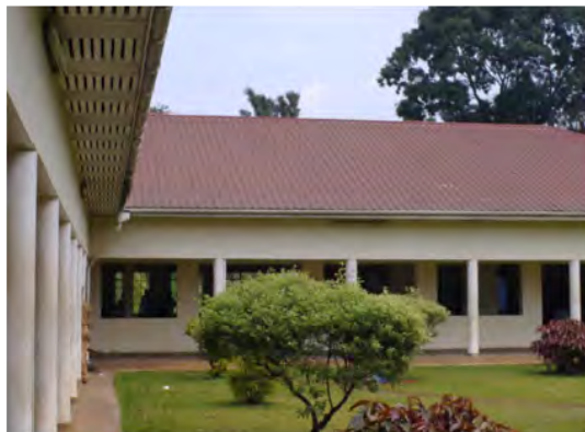
既存外来棟：2003年に建設され、スペースも十分に確保されている。
