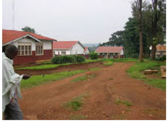
手術・産科病棟建設予定地：老朽化した既存手術棟と厨房を解体した空地を使用する。
