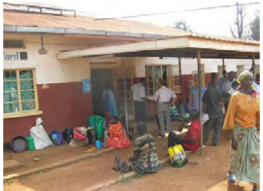
既存産科病棟：建物内に入りきれず、屋外で診察を待つ患者もいる。
