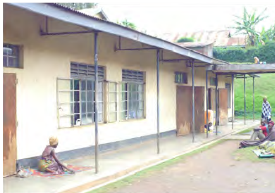
既存手術棟：老朽化しているが、きちんと補修されており、施設の状態は良い。
