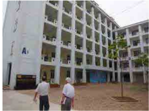
実施機関（UTT）内視察
