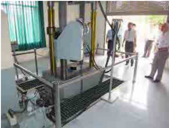
機材設置状況の確認
