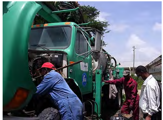
掘削機の整備作業をする EWTEC 職員
