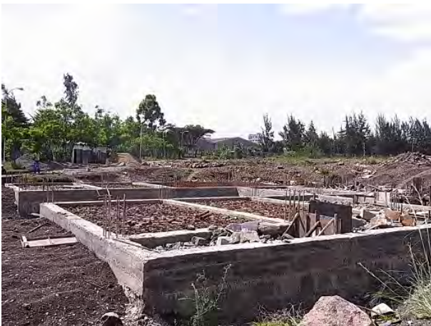
建設中の EWTEC 新校舎
