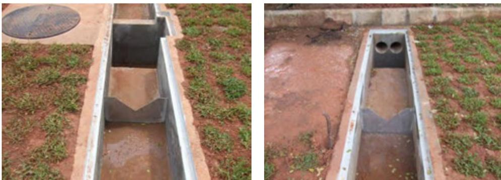
図 4.10-6 三角堰設置状況 (右：流入量(Q2) 左：流出量(Q1) 観測地点)
