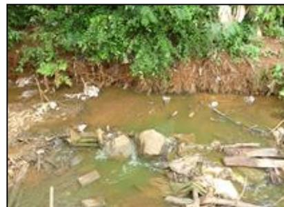
(5) 土堰堤底部からの漏水
