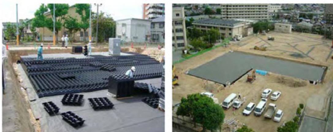
図 8.2-3 オンサイト貯留浸透施設の例（校庭の地下に設置）
