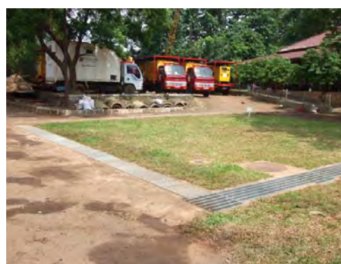
(完成後の地表面)
