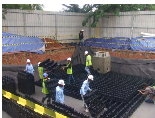
(貯留浸透槽施工中)
