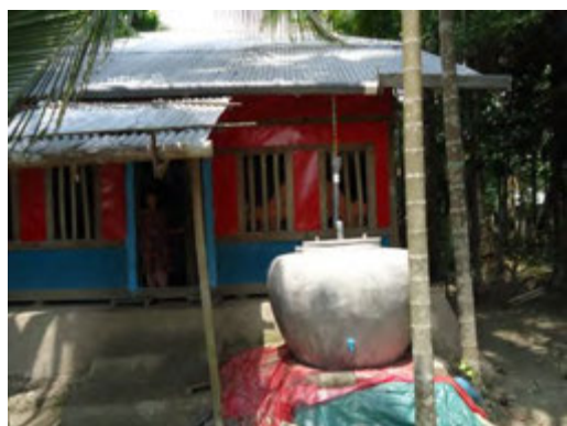
写真 9-19 住宅に設置されたモデルタンク
