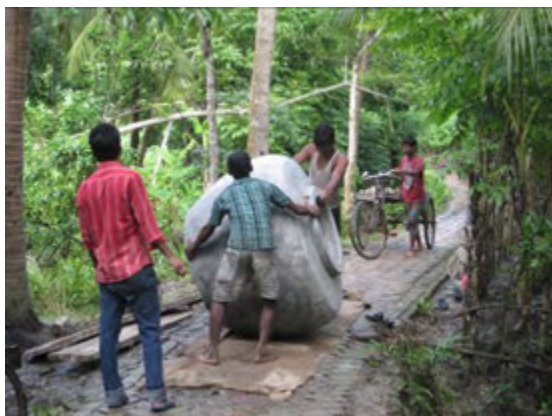
写真 9-31 狭い道でのタンクの 転がし
