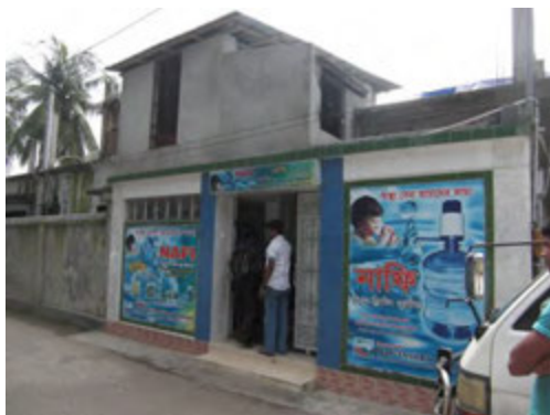
写真 7-3 ボトリング工場外観
