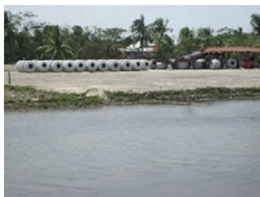
写真 9-40 川沿いに ストックヤードを設置
