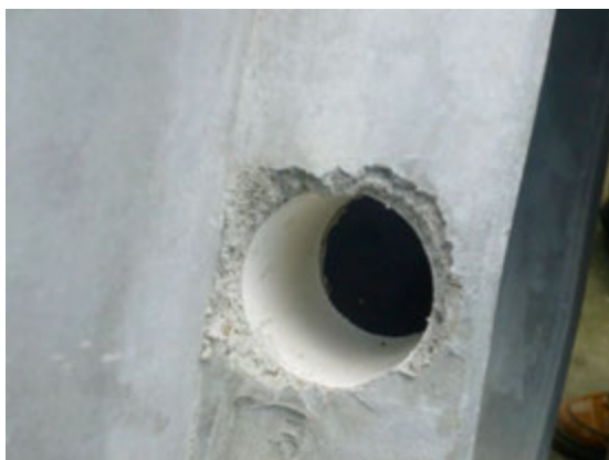
写真 10-7 蛇口取り付け部
