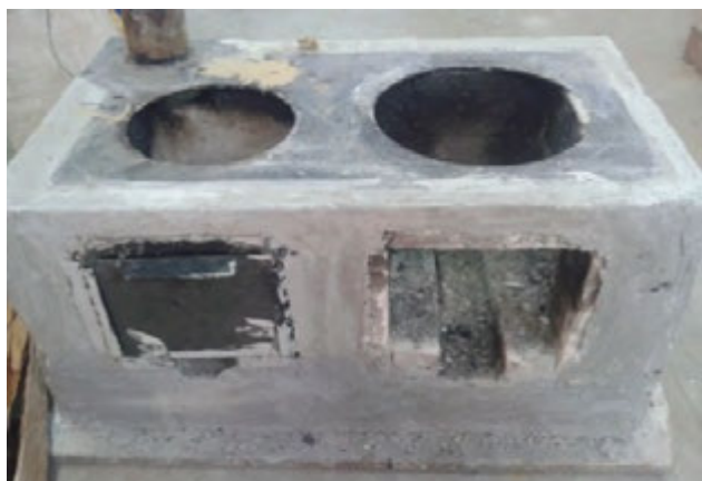
写真 5：落脱した焚口保護枠
