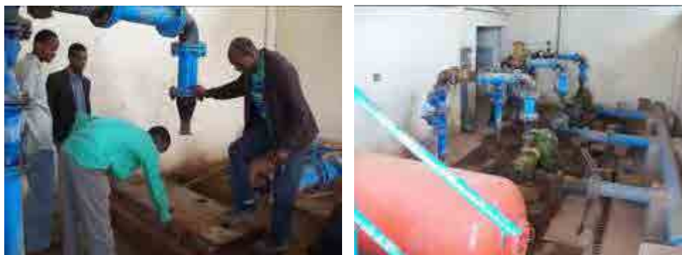
図 2.4: 据付工事実施中の送水ポンプ(左)と送水ポンプ場の全景(右)
