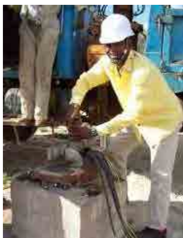
図 2.2: 揚水管の最後の仕上げ接続の様子(左)と建設された発電機小屋(右)
