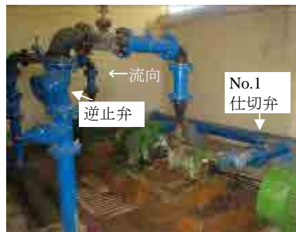
図 2.8: 送水ポンプと配管付帯設備の設置状況
