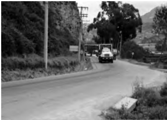
Vías de acceso pavimentadas 1
