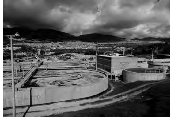
Planta de Tratamiento de Líquidos Percolados
