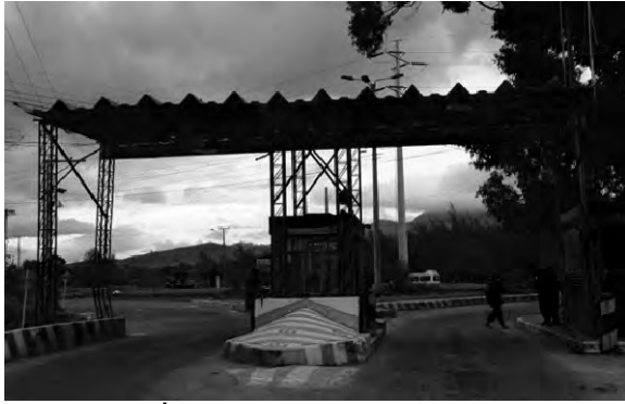
Área de Acceso al RSDJ
