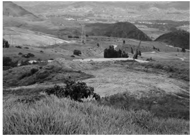
Celda de residuos hospitalarios
