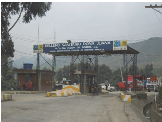
Entrada del Relleno Sanitario Doña Juana
