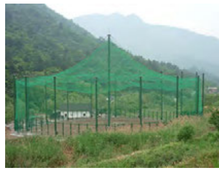
ほぼ建設が完成した大型順化ケージ (寧陝県)
