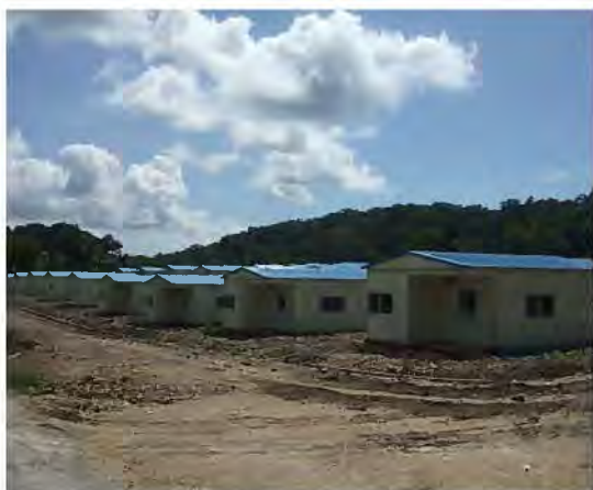
[Mehara] -1. Konstrusaun Estrada & Kanals halo'o hela
