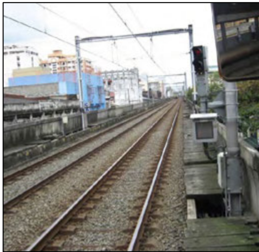
写真 2-1 既存 OCS の門型架線柱
