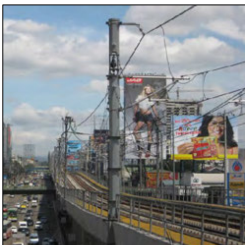
写真 2-2 NEP OCS の H 型架線柱
