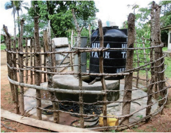
井戸が壊れているため、雨水を利用 Bombali Masangbo CHC (一次医療施設)
