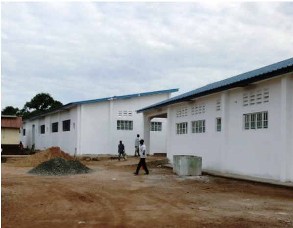
改修中の県病院 Port Loko
