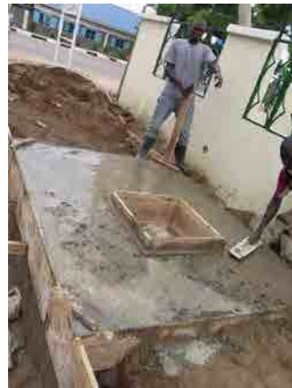
流量計室築造
