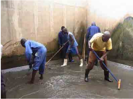
浄水場研修 (原水槽洗浄)
