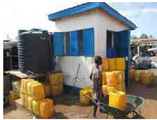
公共水栓 (2000 m3 タンク設置後)
