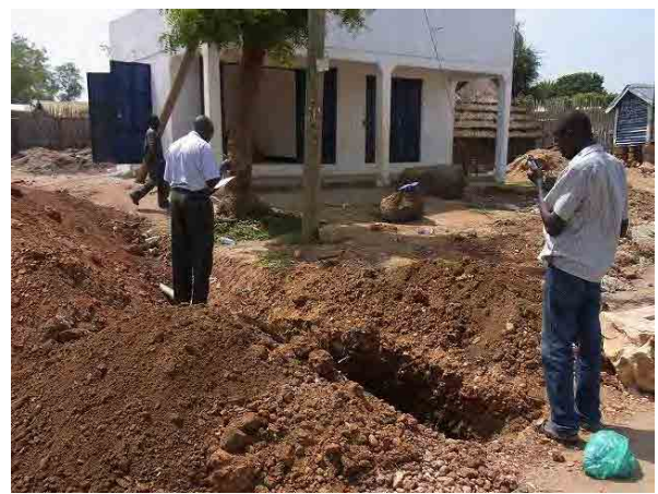
配水維持管理研修 2 (新設管布設の記録)
