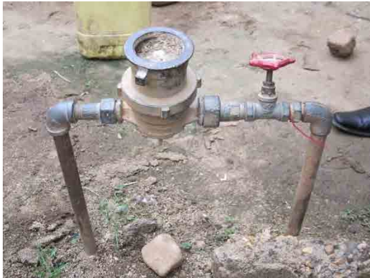
写真 5-2 イギリス植民地時代の 1950 年代に設置された水道メーター(Police line area)
