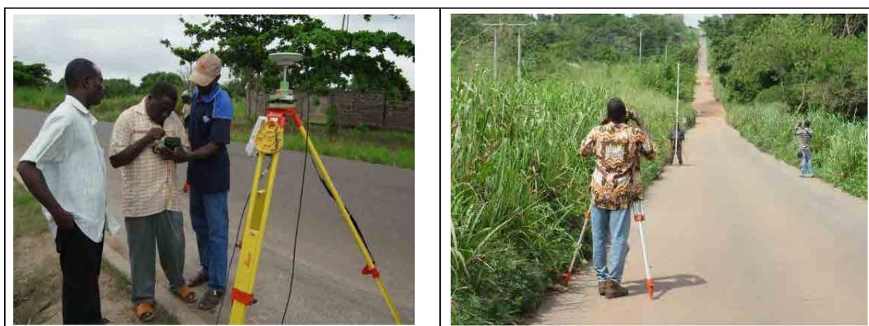
図. 10 標定点測量の様子（左：標定点観測、右：水準測量）
