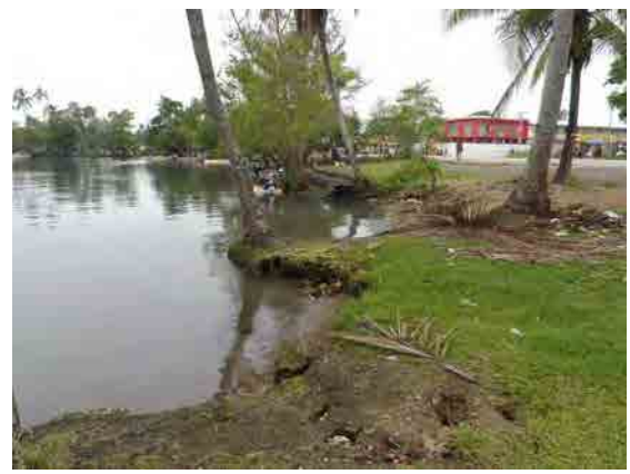
ラグーン岸部の状況： 既存護岸の老朽化（崩壊）が進んでいる。
