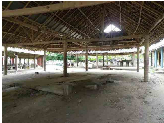
マダン市場の既存市場棟の現況②： 床がなく、遺物の残存で足場が悪い。
