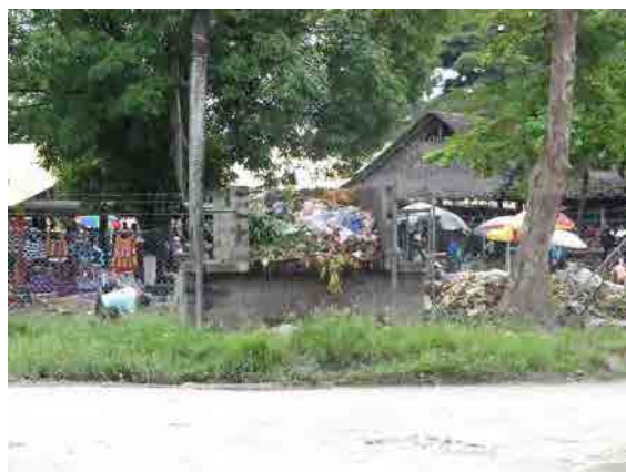
既存ゴミ集積場の状況： 収容能力不足等のためゴミが溢れ、散乱。
