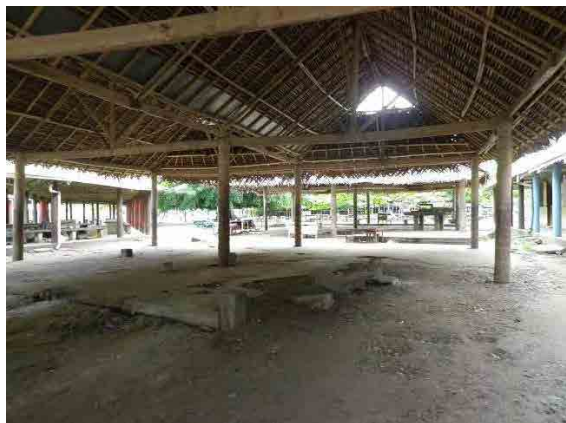
マダン市場の既存市場棟の現況②： 床がなく、遺物の残存で足場が悪い。
