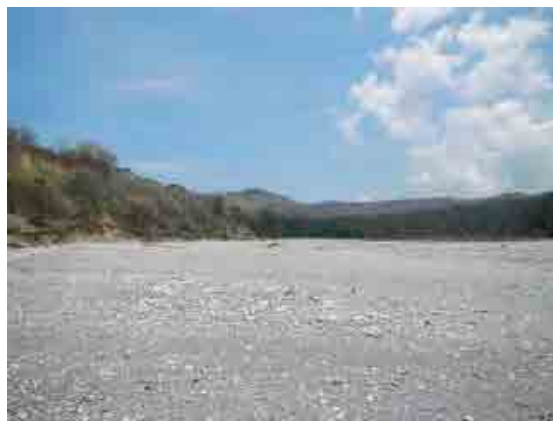
写真-2 頭首工設置候補位置 河川左岸側が大きく右側に蛇行して川幅が狭くなる。また、同箇所にはホーリーストーンがあり、川幅をさらに狭くしている。
