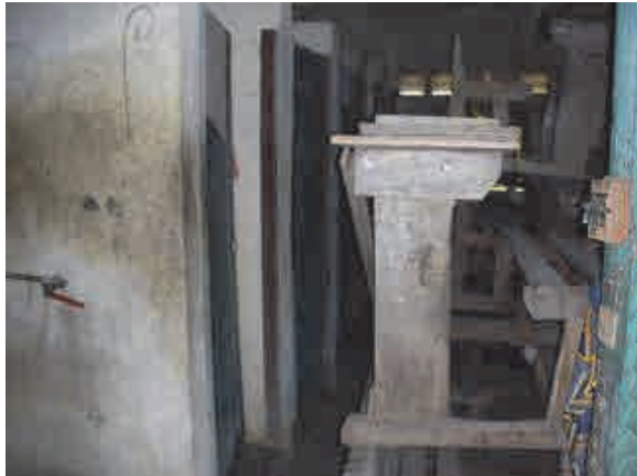
学校に併設されているトイレ。物置になっており、使用されていない。(アボボ・コミュニン)
