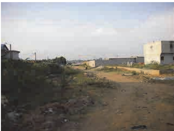
アボボ・コミュニティの道路整備プロジェクトの候補サイト。道路用地内に建物ができ始めている。
