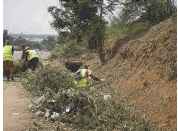
WB の資金により AGEROUTE が実施しているプロジェクトの道路清掃の状況 (アボボ・コミュニティ)
