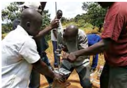
給水用ハンドポンプ施設の修理方法を学ぶ修理担当者(ウガンダ)
