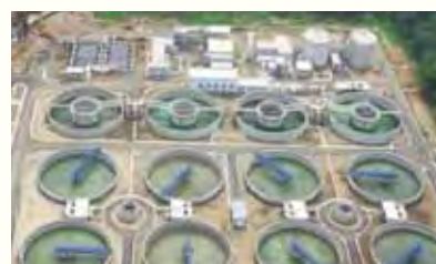
完成した下水処理場
