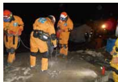
夜間も続く総合訓練で要救助者を救助するためにコンクリートを破砕する救助チーム隊員
