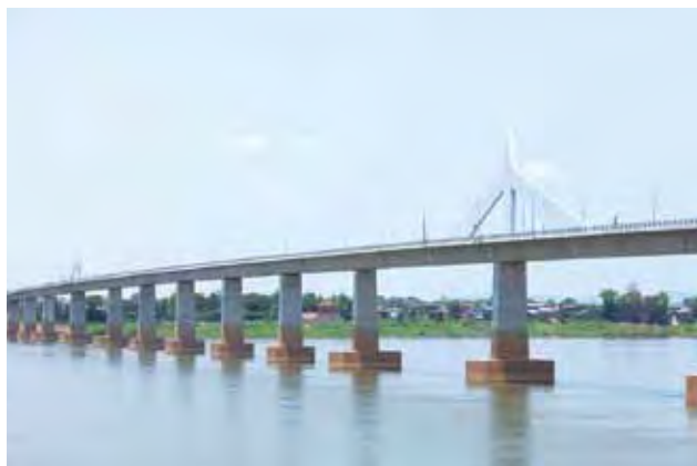
ベトナムからミャンマーまで東西に横断する東西回廊整備の一環として、円借款による支援で建設されたタイとラオスを結ぶ第2メコン国際橋
