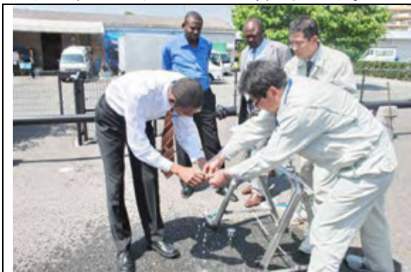
写真 - 18. 蛇口の修理技術の研修
