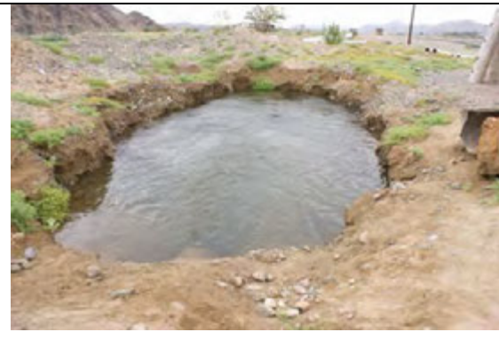
写真-43. バルブ撤去で出来た池
