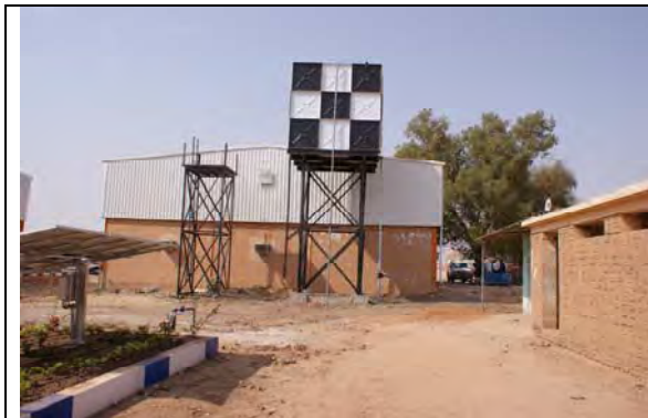
写真-30. 完成した高架タンク
