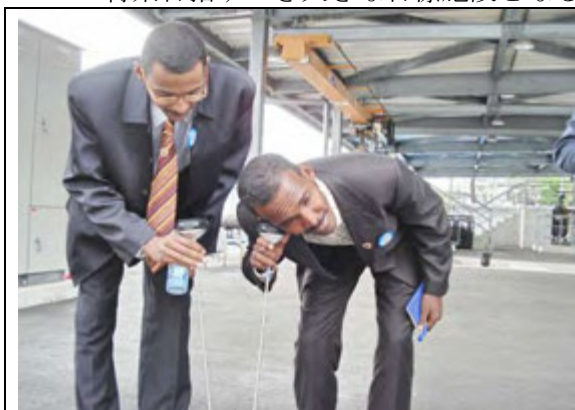
写真 - 14. 漏水探知の実習
