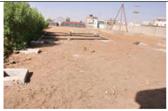
写真-31. 日本モデルの漏水試験教
