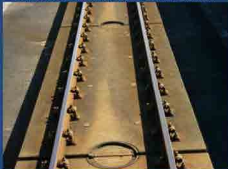
Рельсовый путь со сплошным блочным основанием из плит
