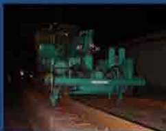
Рихтовка смещения пути в плане с использованием путерихтовочной машины
