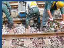
Уплотнение балласта с применением шпалоподбойки
