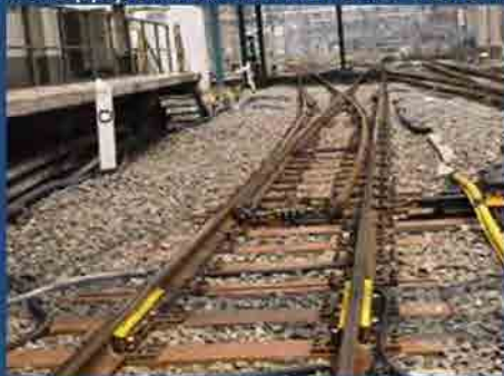
Стрелочный перевод на железнодорожной линии обычного типа
