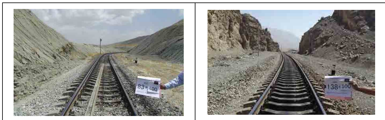
[Рис. 2-6] Посещение строительной площадки до начала обследования
