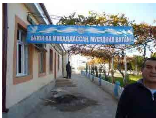
Административное здание депо, которое было отремонтировано собственными силами сотрудников. Здесь находятся аудитории, где проводится обучение сотрудников.
