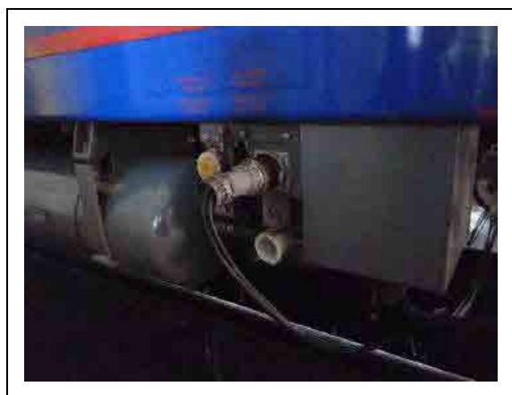
[Рис. 2-33] Блок электропитания
