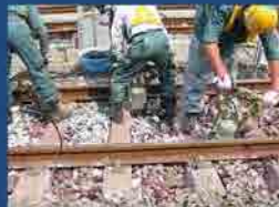
TTによる道床つき固め
