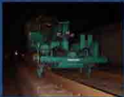
トラックライナーによるスラブ軌道通り整正
