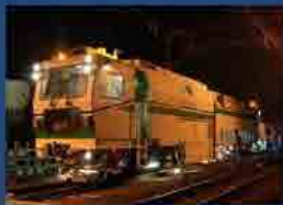
MTTによる軌道整備
